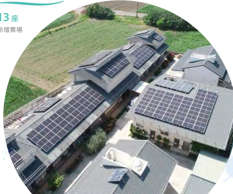
慈善基金會為偏鄉國小校舍屋頂鋪設太陽能板
